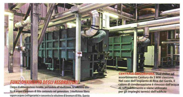
serpentina dell'assorbitore. Il calore di condensazione e di diluizione è rimosso dall'acqua di raffreddamento. La soluzione diluita di bromuro di litio è poi pre-riscaldata nello scambiatore di calore prima di ritornare nel generatore.
